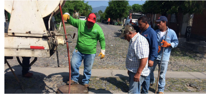
Trabajadores operativos al pendiente de las emergencias en la línea conductora de agua potable.
