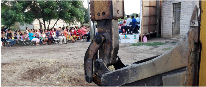
Arranque de obra en Jardines del Llano.
