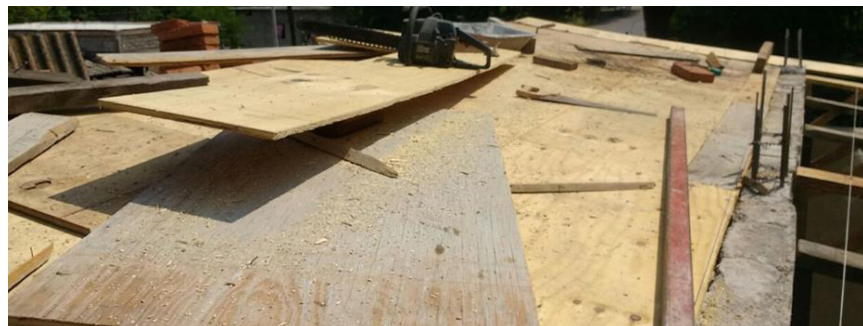
Proceso de construcción de losa de concreto en los apoyos de techo firme.
