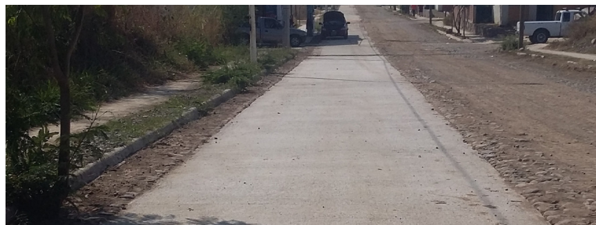
Pavimentación de concreto hidráulico en la calle 16 Sep en Jardines del Llano.
