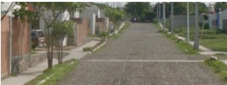
Calle 16 Sep antes de iniciada la obra.
