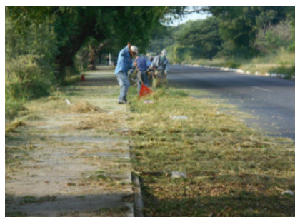
Mantenimiento del andador a Rancho de Villa.
